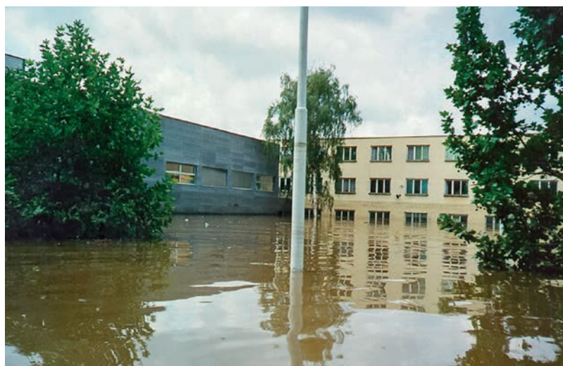
Vodní hladina při povodni kulminovala jen pár centimetrů pod okny prvního patra tehdejšího sídla ČSÚ na Invalidovně.
