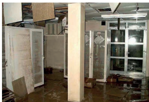
Serverovna v přízemí úřadu byla zaplavena až po strop.
